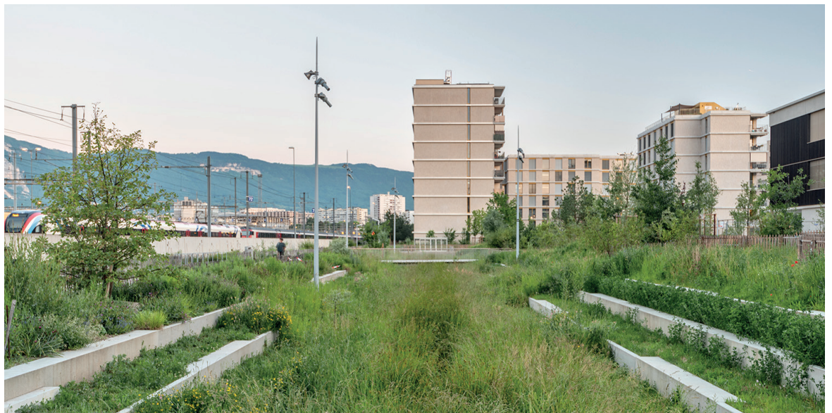
la noue de rétention et ses gradins
